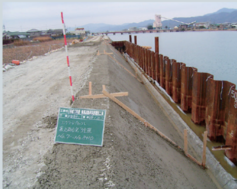
国土交通省発注：東馬詰護岸災害復旧工事にて裏込砕石として利用
