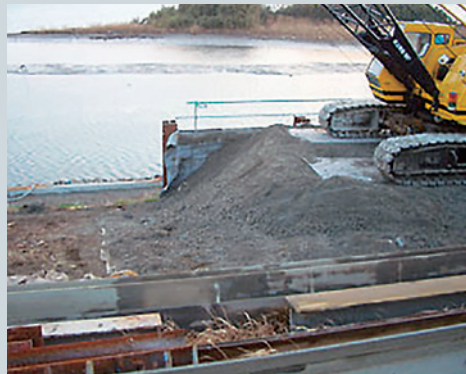
国土交通省発注：中原護岸災害復旧工事にて仮設道路盛土材として利用
