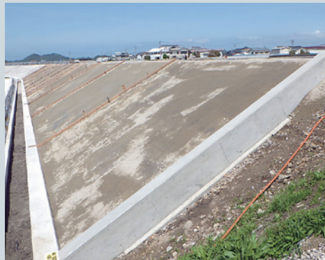
徳島県発注：撫養川・堤防耐震工事に利用
