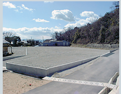
民間工事：宅地造成・盛土に利用
