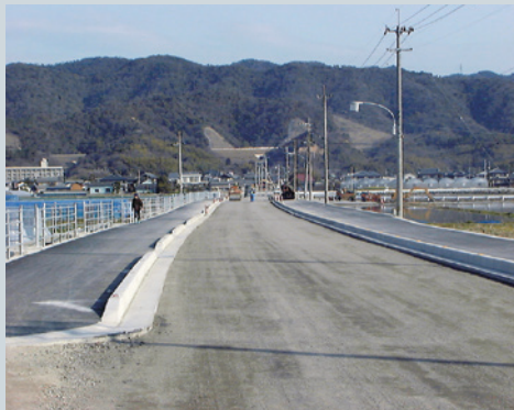
徳島県発注：県道舗装工事にて下層路盤材として利用
