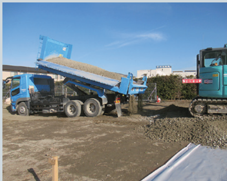
鳴門市発注：鳴門市・北島町共同浄水場整備工事にて造成盛土に利用
